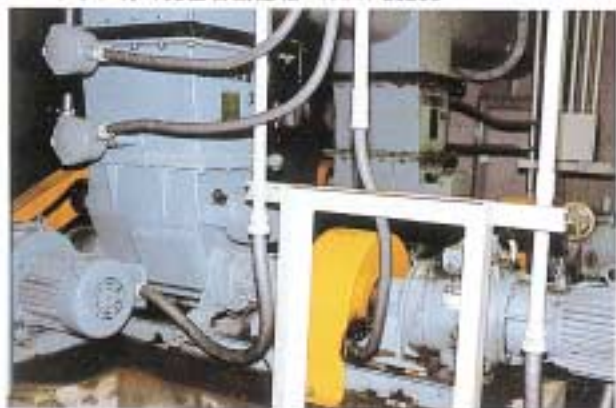
4段型高圧ポンプ HNFA-204B 圧力2.0MPa
