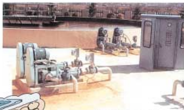
海外でも活躍しています。 韓国で運転中のモノローポンプ 余剰汚泥引抜ポンプ HNP-601CS
