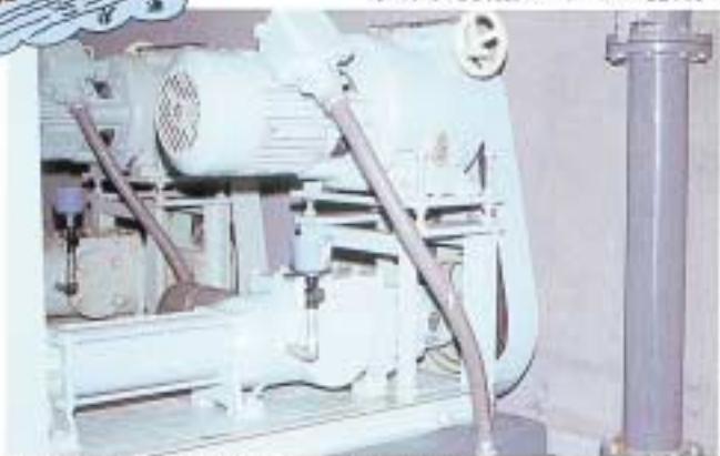
汚泥供給ポンプ HNP-401CS 無段変速機付
